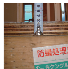
■28ミリの構造用合板の断面
