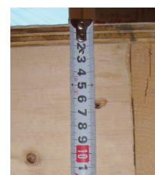
■15ミリの構造用合板の断面(2階床)
