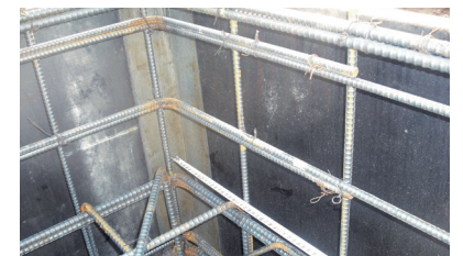
上下に13・10ミリの異形鉄筋をおのおの配してます。
