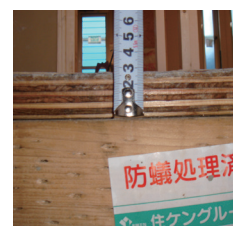
■28ミリの構造用合板の断面
