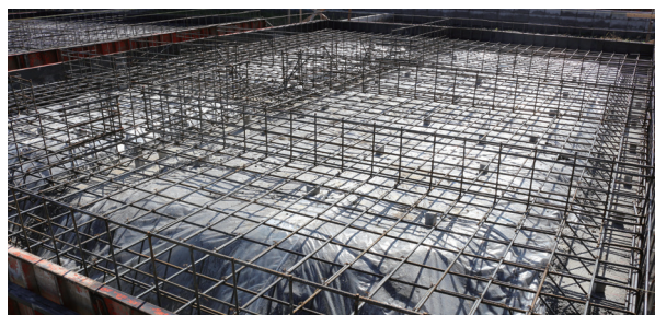
13ミリの異形鉄筋を200ミリ間隔で井桁状に組んでいきます。
