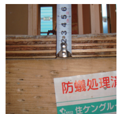
■28ミリの構造用合板の断面
