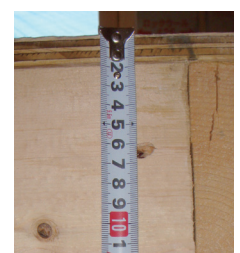
■15ミリの構造用合板の断面(2階床)
