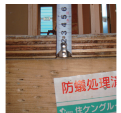
■28ミリの構造用合板の断面
