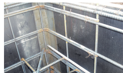
上下に13・10ミリの異形鉄筋をおのの配してます。
