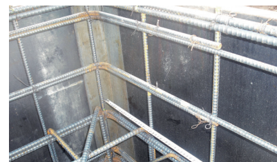
上下に13・10ミリの异形鉄筋をおのの配してます。
