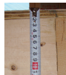
■15ミリの構造用合板の断面(2階床)
