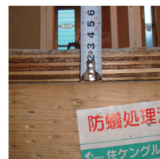
■28ミリの構造用合板の断面
