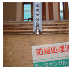
■28ミリの構造用合板の断面
