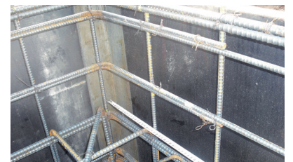
上下に13・10ミリの異形鉄筋をおのおの配しています。
