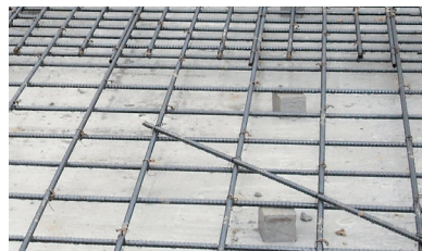
13ミリの異形鉄筋を200ミリ間隔で井桁状に組んでいきます。
