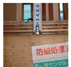
■28ミリの構造用合板の断面
