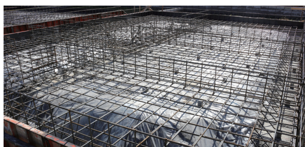
13ミリの异形鉄筋を200ミリ間隔で井桁状に組んでいきます。
