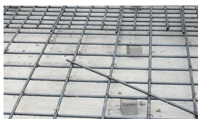
13ミリの异形鉄筋を200ミリ間隔で井桁状に組んでいきます。
